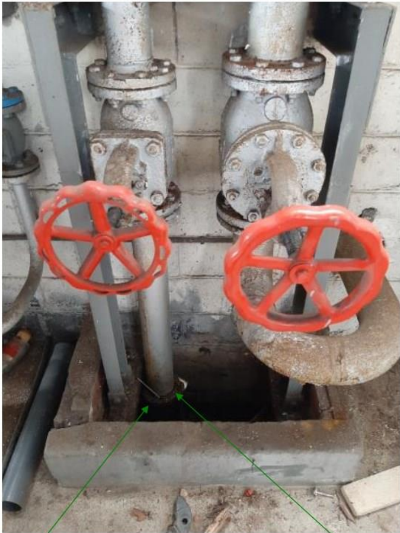
P034 - Non amianté Revêtement bitumineux sur conduite départ eau chaude
