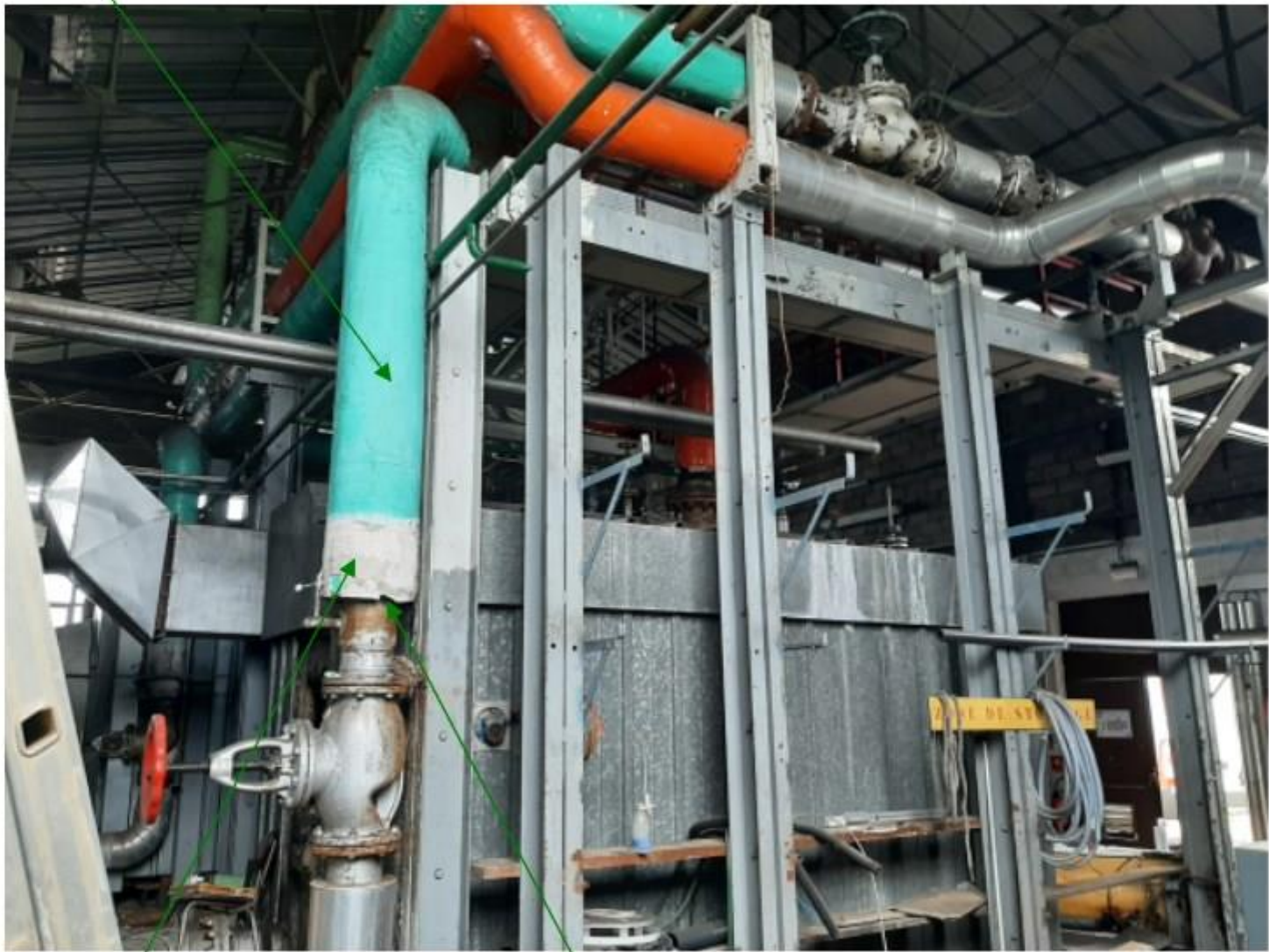
P015 - Non amianté Tresse en partie basse du calorifuge
